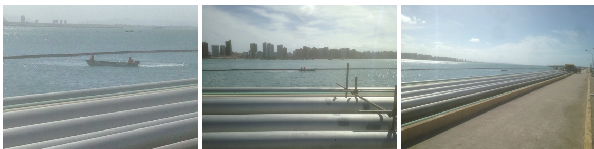
Fotos de registro do simulado de vazamento de combustível, TRANSPETRO/CDC no píer petroleiro. Fonte Primária
